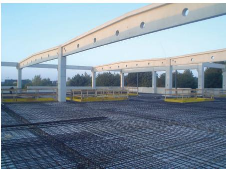
Der Aufbeton ist in den ersten Tagen durch geeignete Maßnahmen (Abdecken, Befeuchten, Schutzfilm) vor dem Austrocknen zu schützen. Sind die Fertigplatten nicht ganz dicht verlegt worden, kann Zementschlämme durch die Fugen laufen. Deshalb sollen die Fugen und Wandanschlüsse nach dem Betonieren gesäubert werden.
