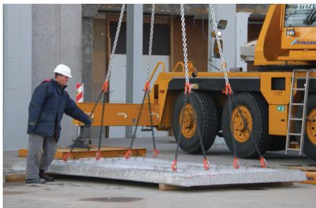
Das Heben der vorgespannten Elementdecke VSE erfolgt mit einem Kettengehänge direkt vom LKW auf das vorbereitete Auflager. Die Hacken des Kettengehanges werden in den Knotenpunkten der Gitterträger eingehängt. Die Einhängpunkte sollen je ca.  $l/10$  der Deckenelementlänge vom Plattenende entfernt sein.
