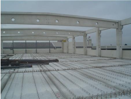
Vor dem Verlegen der oberen Bewehrung ist sicherzustellen, dass die Plattenoberflächen und Stoßfugen frei von gröberen Verunreinigungen sind. Zuerst sind an den Plattenstoßfugen Fugenmatten (oder Stabstahl) gemäß den Angaben im Verlegeplan mittels Abstandhalter auf die Plattenoberfläche aufzulegen. Die restliche obere Bewehrung ist entsprechend den vom Objektstatiker bzw. der Fa. VS-Hohldielen West erstellten Bewehrungsplänen zu verlegen.
