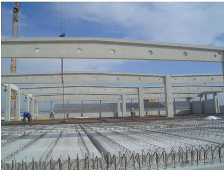
Vor dem Betonieren ist sicherzustellen, dass die Platten und Bewehrungseisen mit den Angaben der Verlege- und Bewehrungsplänen übereinstimmen und nach Lage und Höhe genau ausgerichtet worden sind. Die Plattenoberflächen sind vorzunässen, jedoch dürfen keine Wasserlachen auf den Platten stehen bleiben. Der Aufbeton (gemäß Angabe am Verlegeplan) ist möglichst gleichmäßig aufzubringen und zu verdichten.
